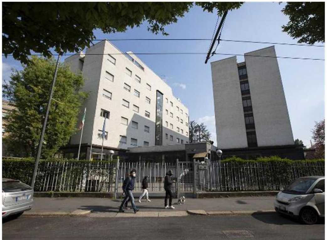
Dalla Regione Lombardia un finanziamento di 254mila per la residenza Bassini, in comodato d'uso per altri 25 anni
